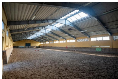
Hala treningowa (rozprężalnia) 60 m x 20 m
